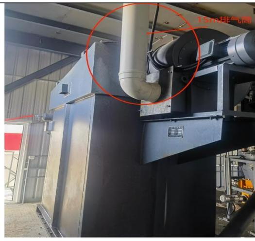
散装、搅拌工序脉冲式除尘器+排气筒
