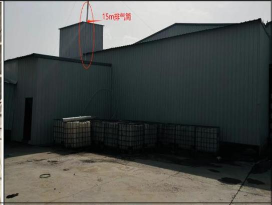
全封闭料仓+上料工序排气筒
