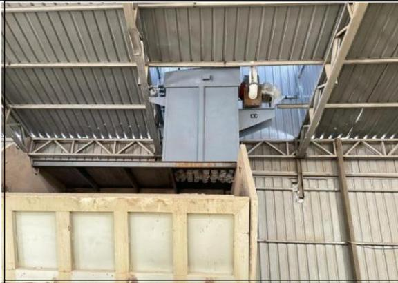
上料工序脉冲布袋除尘器+集气罩
