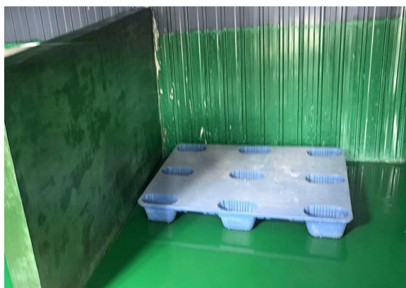
危险废物贮存间
