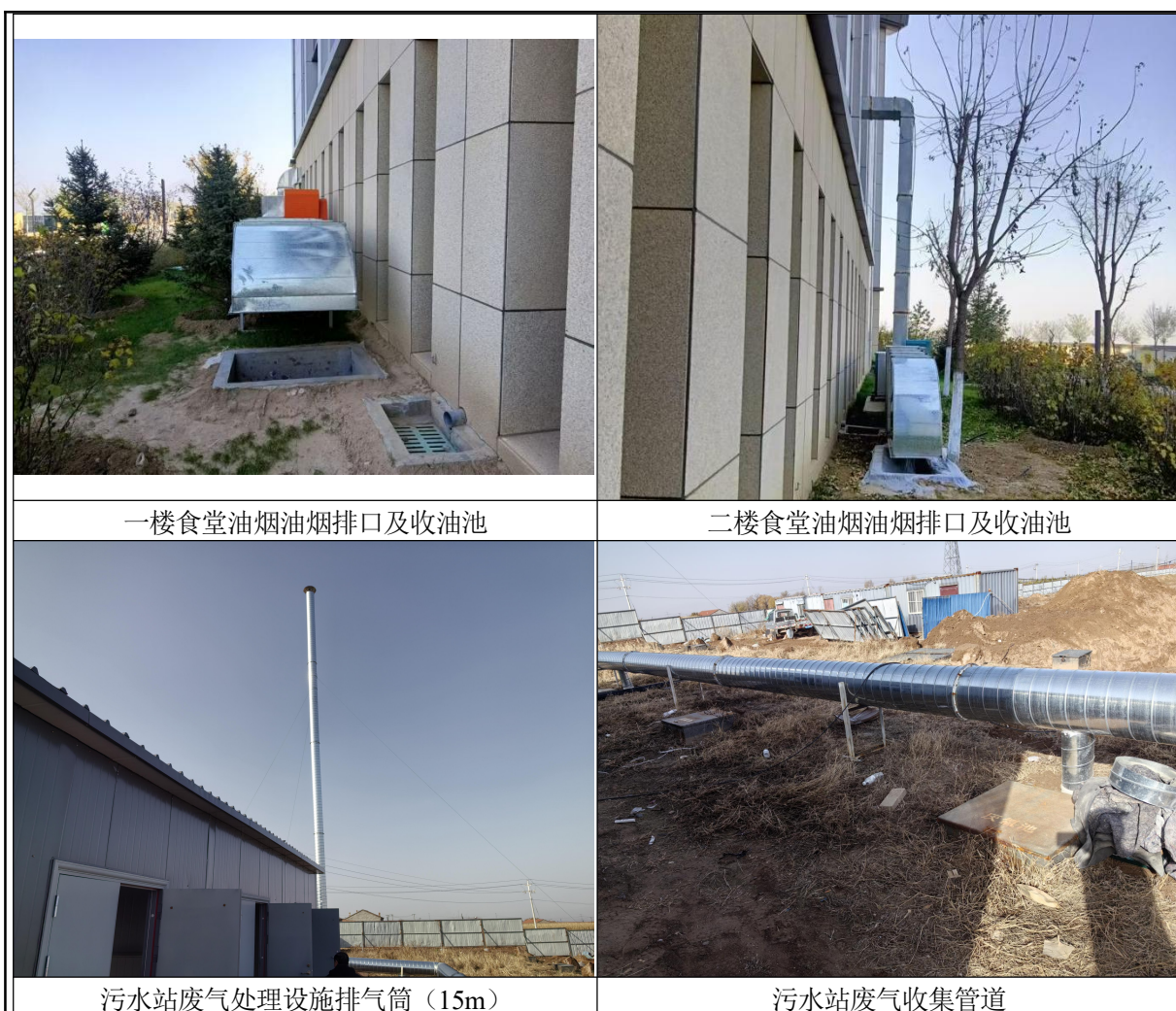
图 3-2 废气产生环节及废气处理设施现场照片
