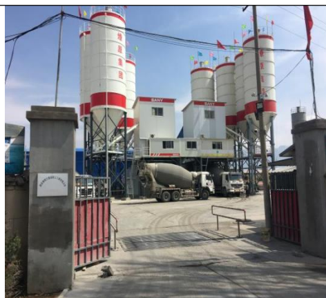
全封闭搅拌楼
