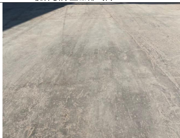
厂区内地面硬化
