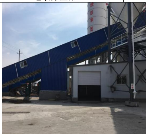
全封闭输送廊道
